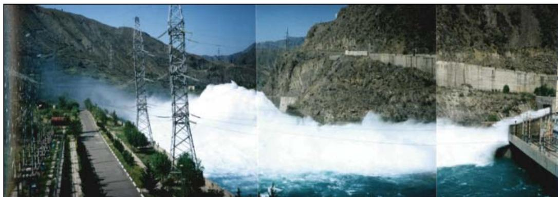
Рис. 1. Распространение компактной струи и водяной пыли при совместном пропуске по глубинному и поверхностному водосбросам расходов воды  $Q_{ПВС} = Q_{ГВС} = 450 \text{ м}^3/\text{с}$ .
