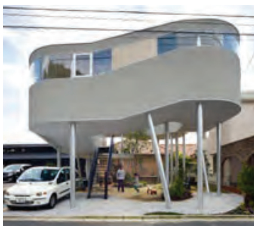
Рисунок 12 – Дом на ножках «Toda House», архитектор Кимихайко Окада. План участка, план этажа, общий вид дома
