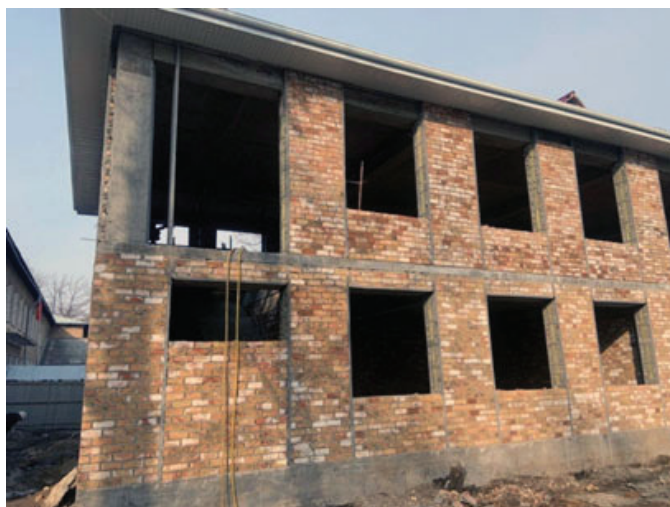
Рисунок 9 – Строительство пристройки к школе № 19
