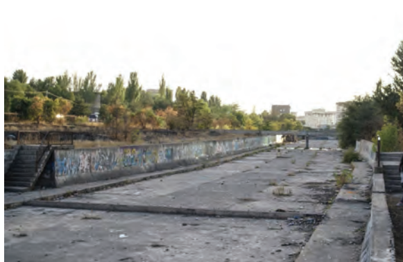
Рисунок 13 – Бетонное русло Южного Чуйского канала
