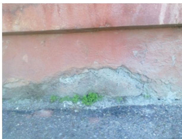
Рисунок 3 – Разрушение фундамента
