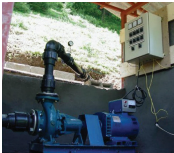
Рисунок 5 – МикроГЭС радиального течения с турбиной Френсиса 5 кВт
