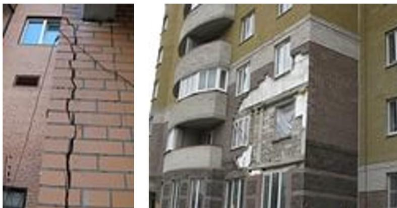
Фото 1 – Дефекты трехслойных стен с фасадной облицовкой из кирпича
