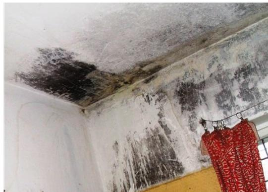
Фото 2 – Дефекты трехслойных стен внутри помещений
