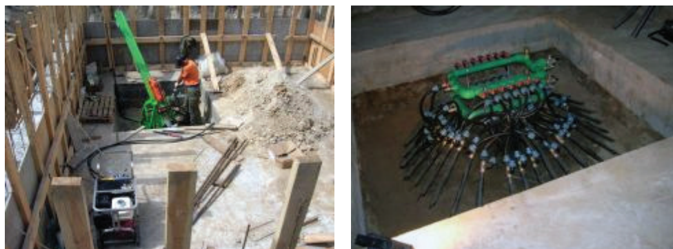
Рисунок 4 – Монтаж установки кластерного геопольа
