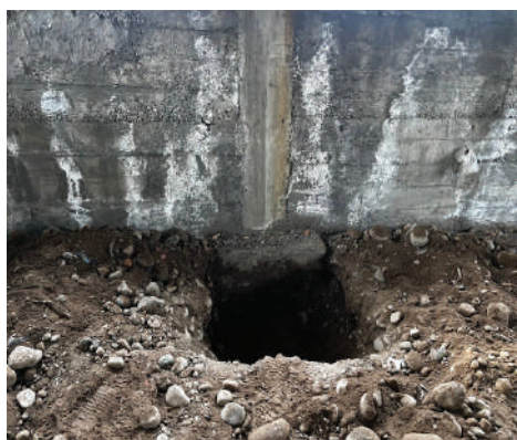
Рисунок 4 – Выполненный шурф в осях «1/В»
