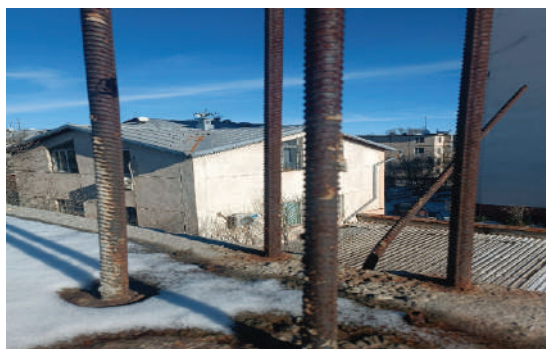
Рисунок 6 – Открытый участок колонны в осях «4/Б»
