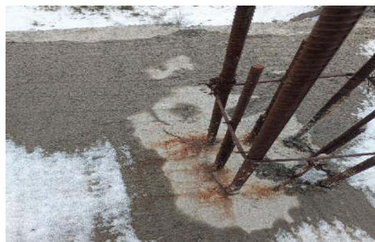
Рисунок 7 – Открытый участок колонны в осях «4/А»
