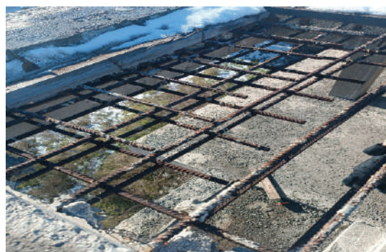
Рисунок 9 – Открытый участок плит перекрытий между осями «3 и 4» и «А и Б»
