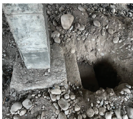
Рисунок 5 – Выполненный шурф в осях «2/В»
