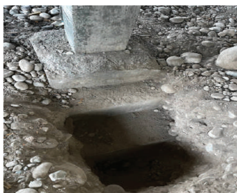
Рисунок 5 – Выполненный шурф в осях «2/В»
