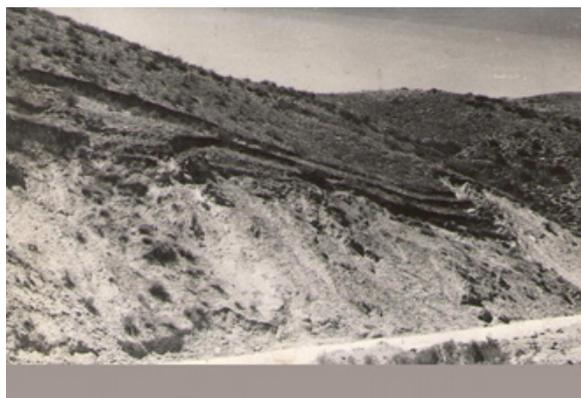
Рисунок 1 – Характерная полувыемка на склоне, разрушившая плодородный слой почвы толщиной 20–30 см
