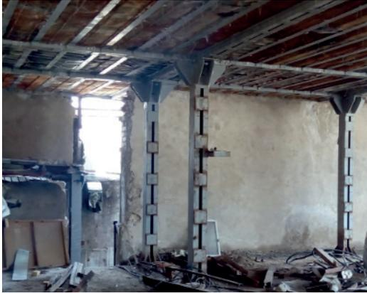
Рисунок 4 – Жесткий узел с опорными столиками в строящемся кафе, г. Бишкек
