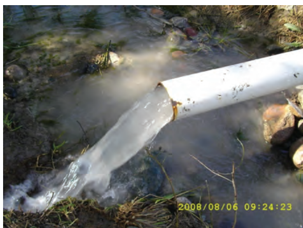
Рис. 6. Выход поднятой воды гидротараном на высоту 1,85 м в участковый распределитель парковой зоны факультета АДКС КРСУ
