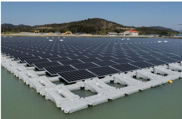
Рисунок 1 – Плавающая солнечная электростанция
