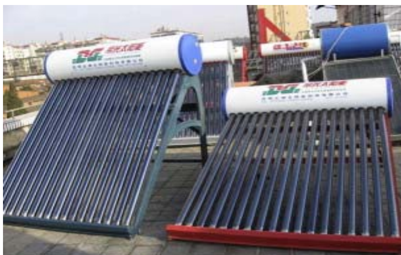
Рисунок 1 – Одноконтурные солнечные водонагреватели
